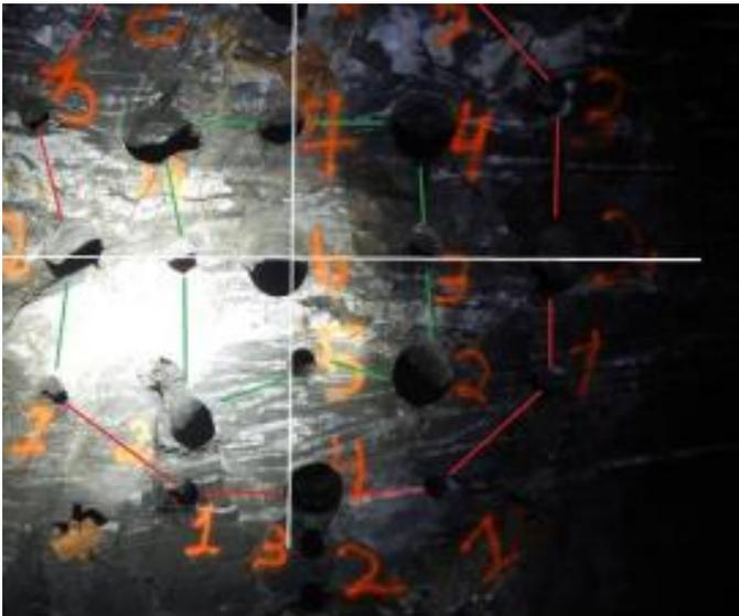
Figura 5: Execução da perfuração do slot com DL 421 em ângulo lateral de 45°.
